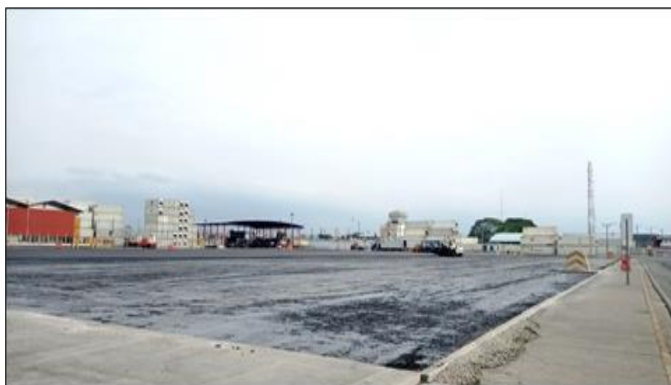
Imagen No. 3 Pavimentación del Patio No. 7
