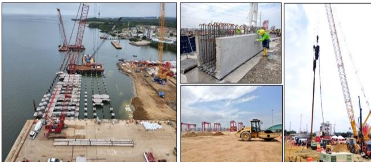
Imagen No. 2 Construcción Muelle #6
