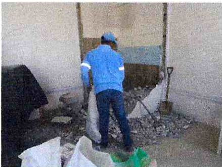
TRABAJOS DE DESMONTAJE DE PIEZAS SANITARIAS, PUERTAS Y DEMOLICIÓN DE PAREDES EN ÁREA DE BODEGA DE CONTROL DE BIENES
