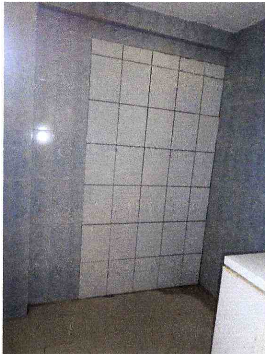
TRABAJOS DE MAPOSTERÍA, ENLUCIDO, COLOCACIÓN DE CERÁMICA DE PARED EN ÁREA DE BAR DE CENTRO DE CAPACITACIÓN
