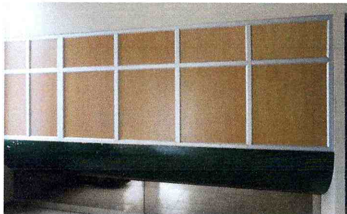
TRABAJOS DE MONTAJE DE PUERTA METÁLICA PRINCIPAL Y ADECUACIÓN DE MAMPARA DE ALUMINIO Y VIDRIO EN AREA ALEDAÑA A SUINSA (EXBANCO DE MACHALA)
