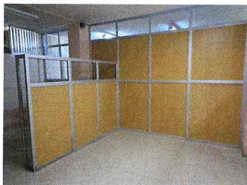
TRABAJOS DE DESMONTAJE, MONTAJE Y MONTAJE DE MAMPARAS DE ALUMINIO, VIDRIO Y MADERA EN EL DPTO. FINANCIERO, E INCLUSIVE DESMONTAJE DE PUERTAS DE ALUMINIO Y VIDRIO
