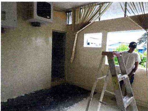
TRABAJOS DE DESMONTAJE DE PUERTAS, MAMPOSTERÍA, EMPASTE, PINTADO Y REPINTADO EN OFICINA DE CONTROL DE BIENES
