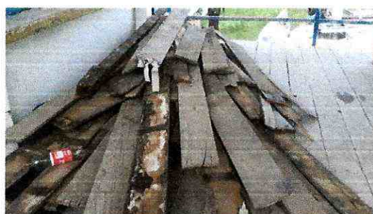
Mal estado del entablado desmontado
