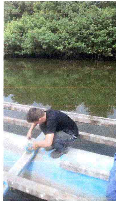
Reposición de elementos de acero y pintura epóxica
