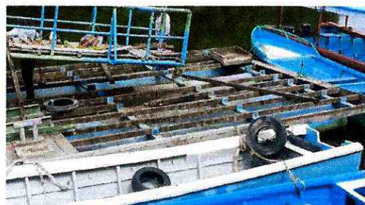
Mal estado del entablado desmontado
