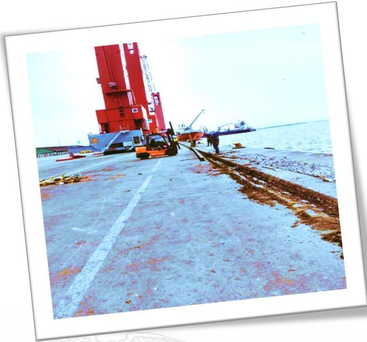
Los rieles cubrirán 600 metros del amplio muelle y al tener el carácter de rieles especiales. En el muelle 5 se ejecuta la rotura de hormigón montaje e instalación de 600 metros de nuevos rieles.
