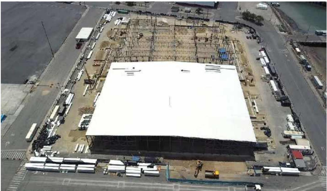
La integridad de la bodega está asegurada mediante una estructura de acero sostenida por cimentaciones de hormigón armado, complementadas por un muro de corte continuo alrededor del perímetro de los cimientos.
